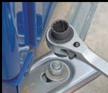
设备管道支架的松紧
